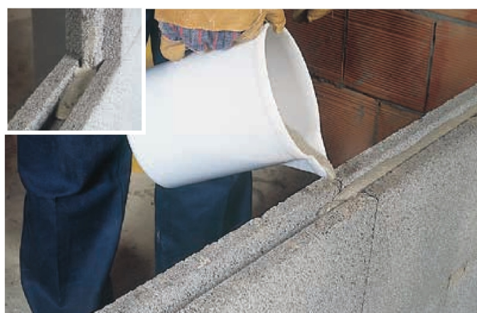
Versare la malta di posa nell'incavo dei blocchi utilizzando un recipiente a bicchiere.
