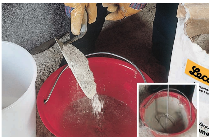
Preparazione della Malta Lecalite (o boiaccia di cemento) da miscelare con trapano munito di frusta o con cazzuola.
