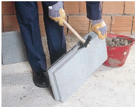
Rompere l'incastro maschio per la posa del primo corso.
