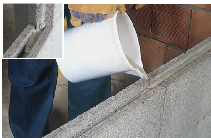
Versare la malta di posa nell'incavo dei blocchi utilizzando un recipiente a bicchiere.
