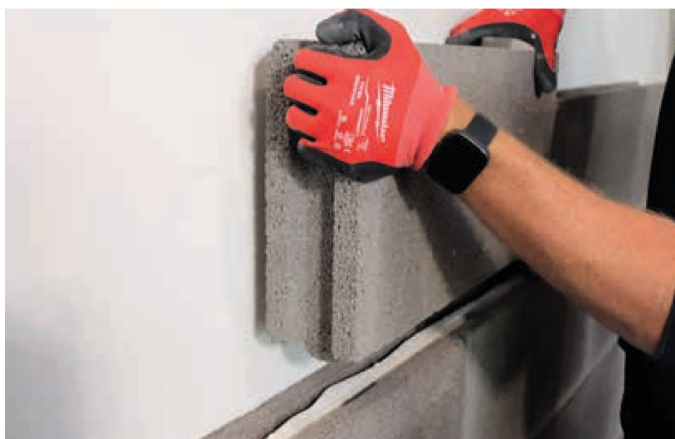
Posa a incastro di Lecalite con Rasatutto e Rasatutto OK (consumo 3-5 kg/m 2 di parete). L'incavo orizzontale va riempito per circa metà della sua altezza.
