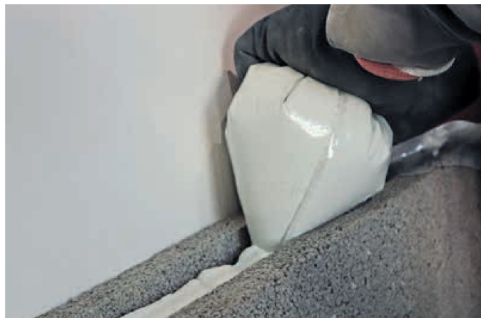
La posa risulta essere semplice e veloce anche con l'applicazione con sac à poche per l'edilizia, e permette di realizzare l'intera parete in tempi brevi.
