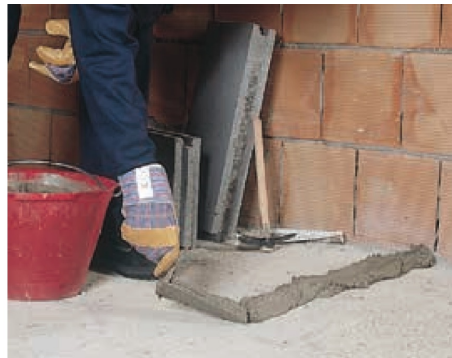
Stendere uno strato di malta e posare i blocchi con l'incavo verso l'alto.
