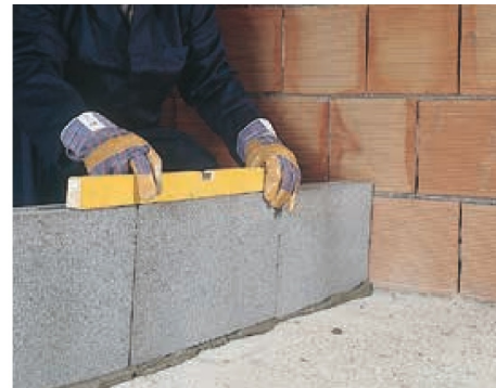
Controllare la posa in bolla del primo corso.
