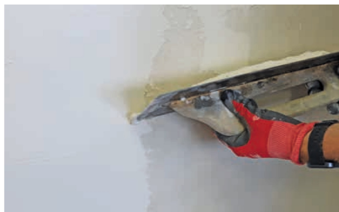
Stesura della mano di finitura con Rasatutto e Rasatutto OK.
