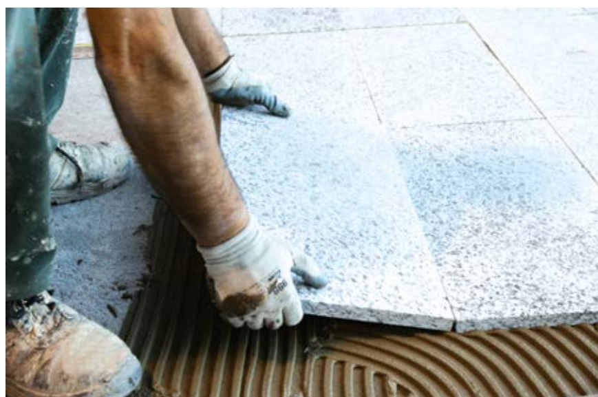
Fasi di posa del massetto in Lecamix Forte Professional e pavimentazione con lastre di granito.
