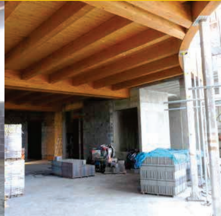
Parete interna in Lecablocco Fonoisolante.
