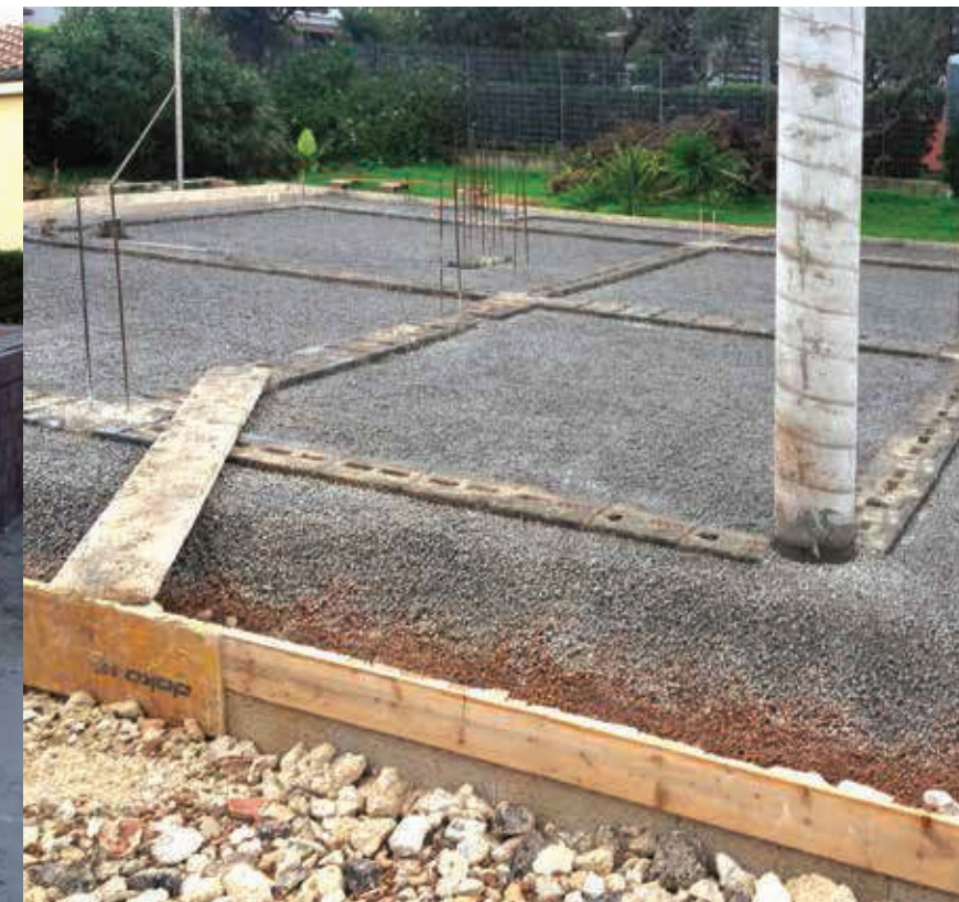
Vespai isolati controterra con argilla espansa Termopiù.
